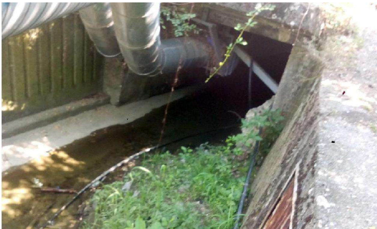
Слика 10. Лозничка река ID:RPMLo7 (смајњен протицајни профил услед објекта у кориту)
