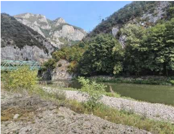
Слика 12 Фото приказ обале, поглед на челични мост
