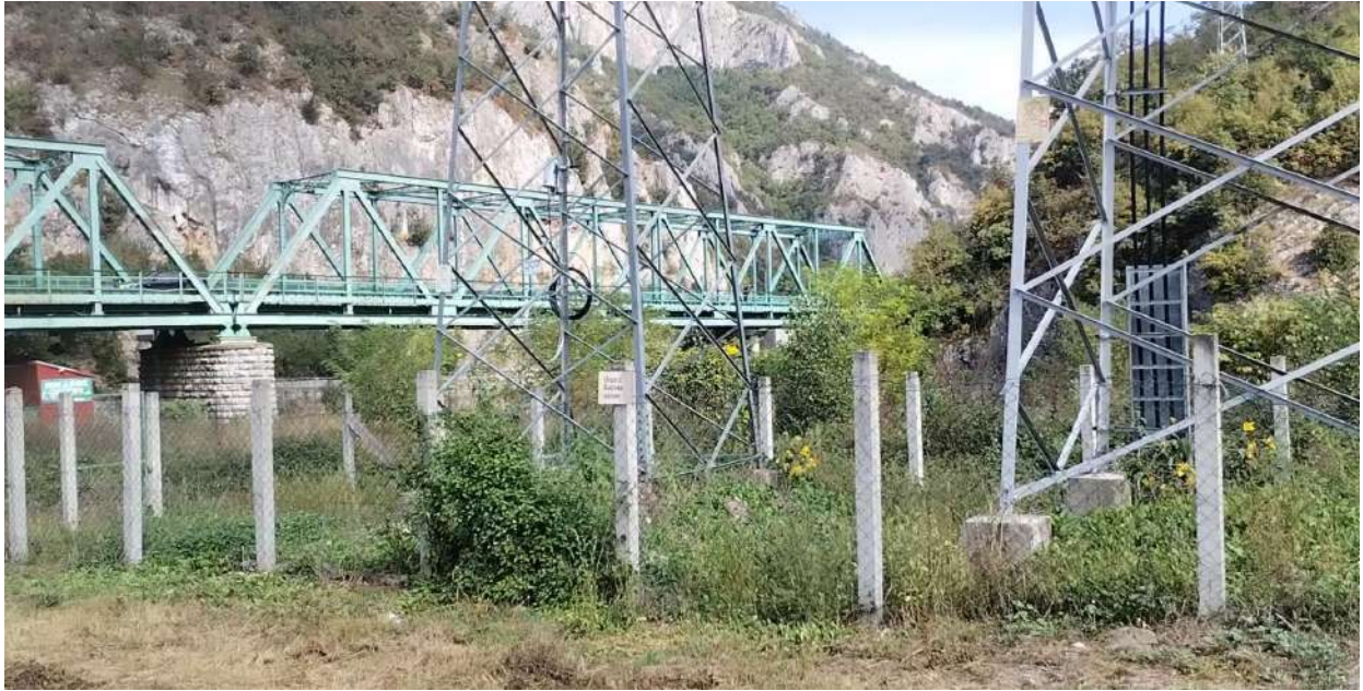
Слика 6 Далековод на левој обали Западне Мораве
