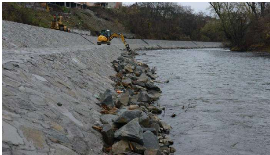
Слика 7. Пример готове облоге од камена у цементном малтеру
