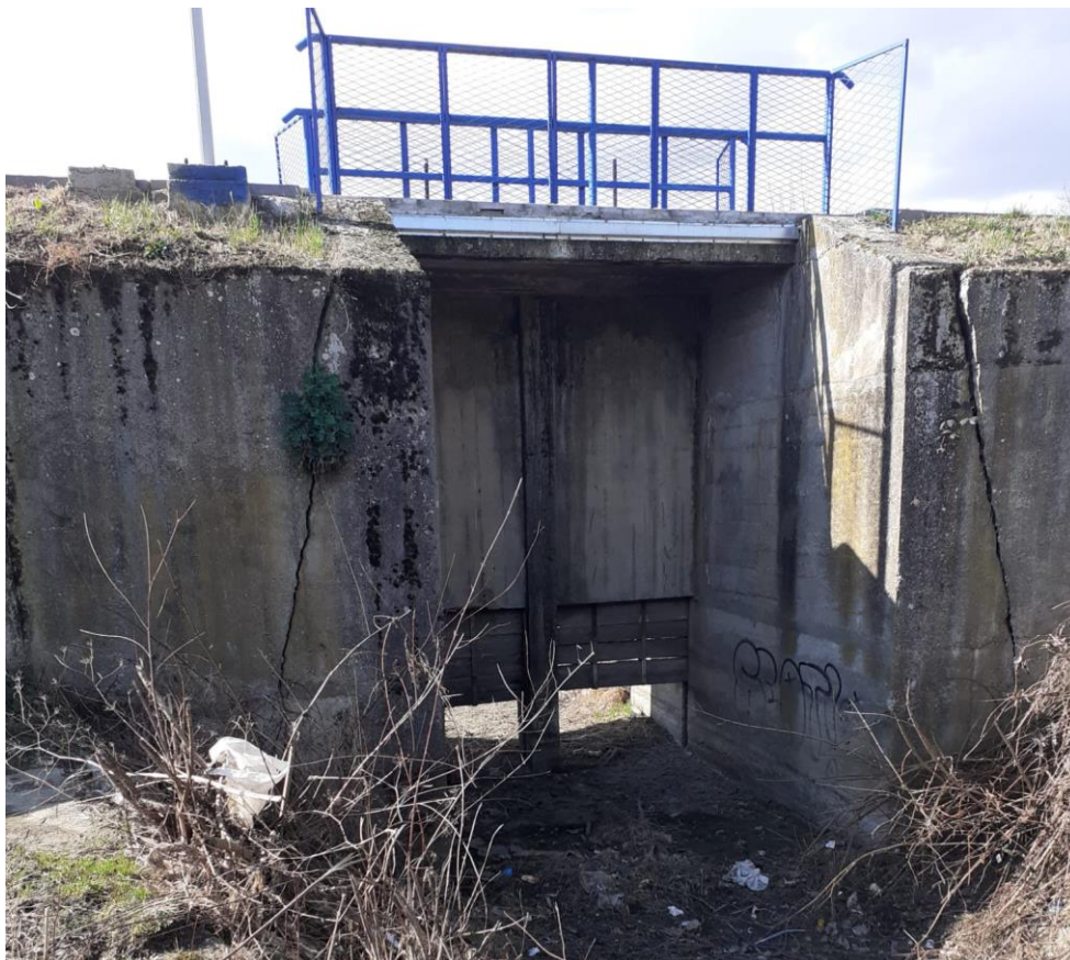
Слика 30 Приказ армиранобетонске конструкције уставе (са обиласка терена)
